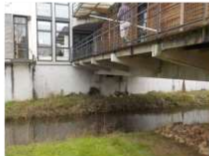
Vue vers l'aval
